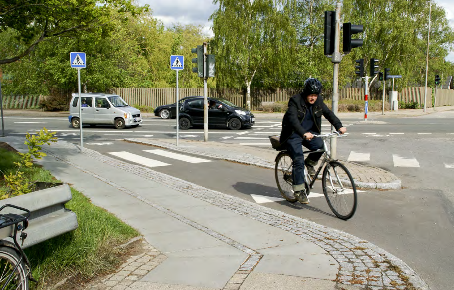
Figur 1. En cykelshunt kan spare cyklister for et stop ved at lede dem uden om signal.
