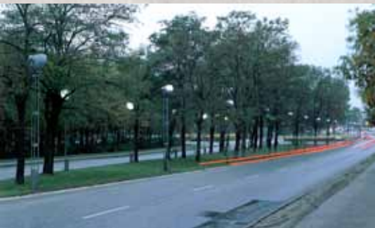
Figur 3. Medlys-lygterne på Vallensbæk Torvevej. Adskillelsen af kørebanerne på Vallensbæk Torvevej gjorde, at der ikke opstod modlysproblemer. (Foto: Bent Ryberg, 1993).
