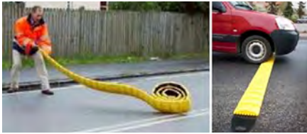
Figur 2. Eksempler på midlertidige bump. Fra Håndbog om afmærkning af vejarbejder, september 2017, figur 7.57. s 182.
