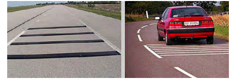
Figur 4. Eksempler på mobile og stationære rumlestribes. Fra Håndbog om afmærkning af vejarbejder, september 2017, figur 7.58, s 182.]
