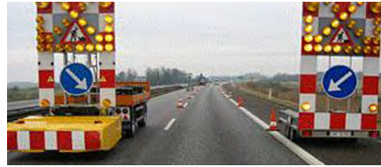
Figur 3. Eksempel på portopstilling med afmærkningsvogne. Fra håndbog om afmærkning af vejarbejder, september 2017, figur 7.60, s 183.
